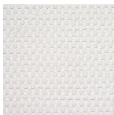
Närbild av ytskikt
